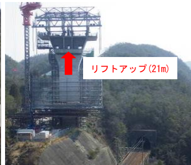
横移動後・リフトアップ前
