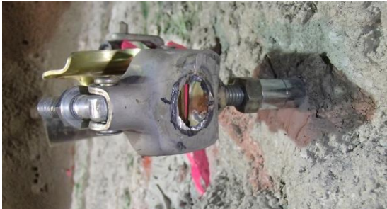
写真2 取付治具(アンカー+クランプ)
