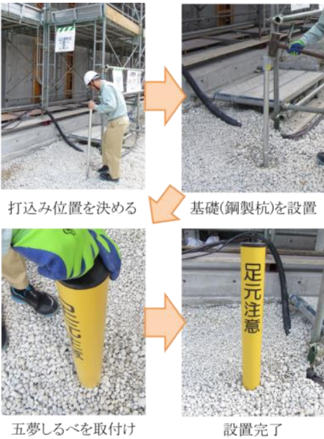
写真-1 施工手順
