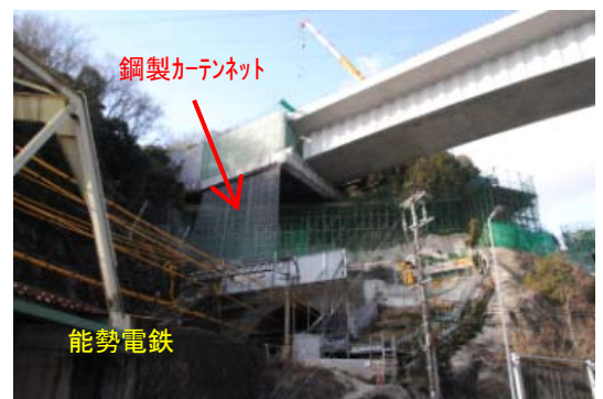
写真-3 A2 側径間の施工状況
