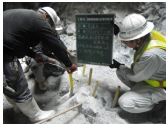
写真-2 深礎杭の低振動破碎
