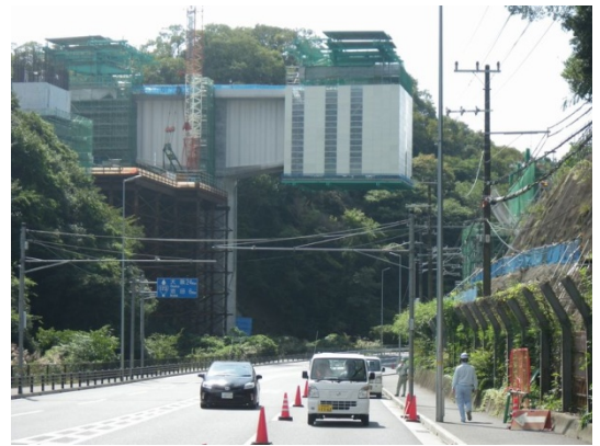
写真-1 交差物上を通過する移動作業車
