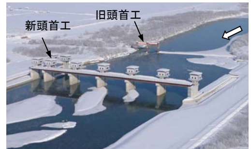
図1 石狩川頭首工
