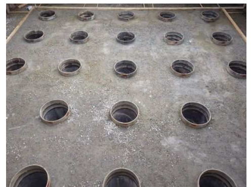
写真-2 施工完了状況
