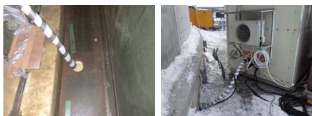
写真-3 基礎版排水孔からの注入ホースの取込み状況
