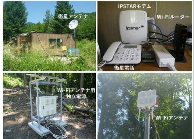
写真-1 衛星通信機器の設置状況
