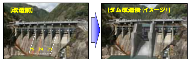
既設ラジアルゲート8門のうち、中央2門を撤去後、越流天端を約9.3m切り下げてラジアルゲートを1門設置
