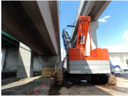
写真-1 鉄道営業線近接工事での適用事例
