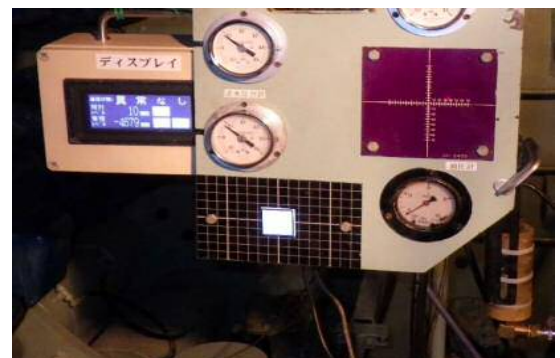
写真-1 マシン内部
