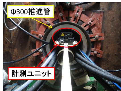
図4 計測ユニット設置
