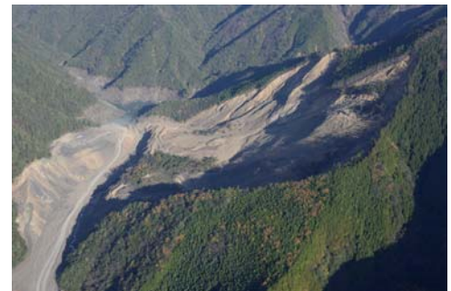
写真-1 実施現場全景
