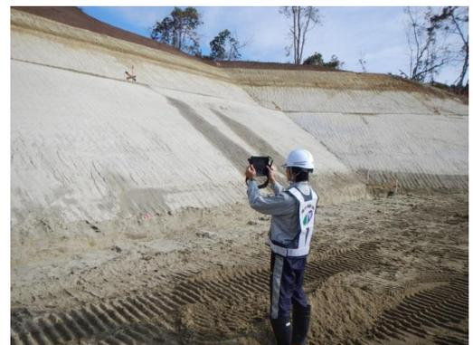
図-3 タブレットによる法面写真撮影状況
