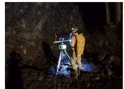
写真-2 切羽の形状測定状況
