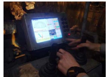
写真-1 セミオート削孔状況
