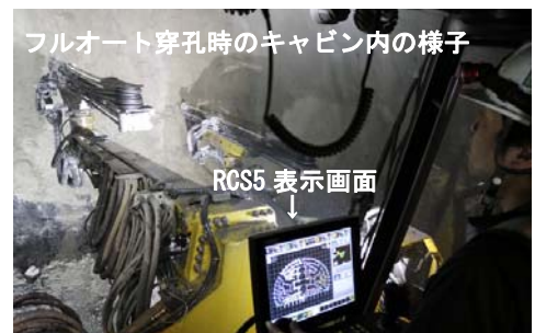
写真-2 専任オペレータ 1 名による穿孔状況
