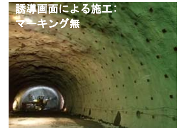
写真-4 ロックボルトの打設状況
