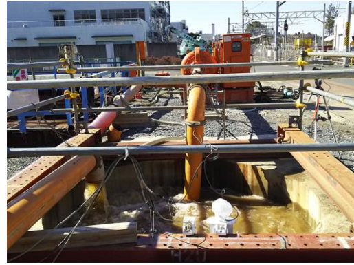
写真-2 検証試験設備(模擬杭孔φ2,700mm)
