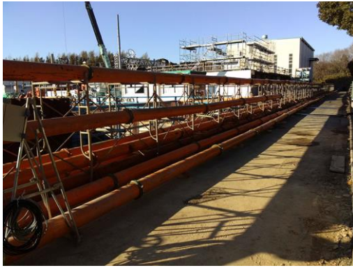
写真-1 検証試験設備(送排泥配管:400m)
