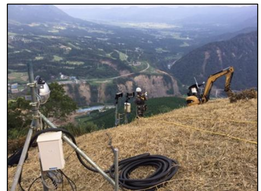
写真-1.2 無人化施工状況 2
