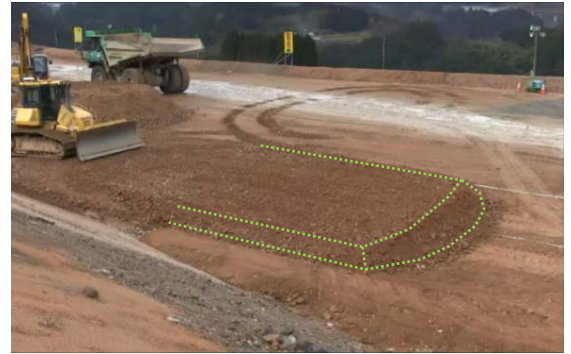
図-5 自動まき出しの結果 (フィルター材、幅 10m)
