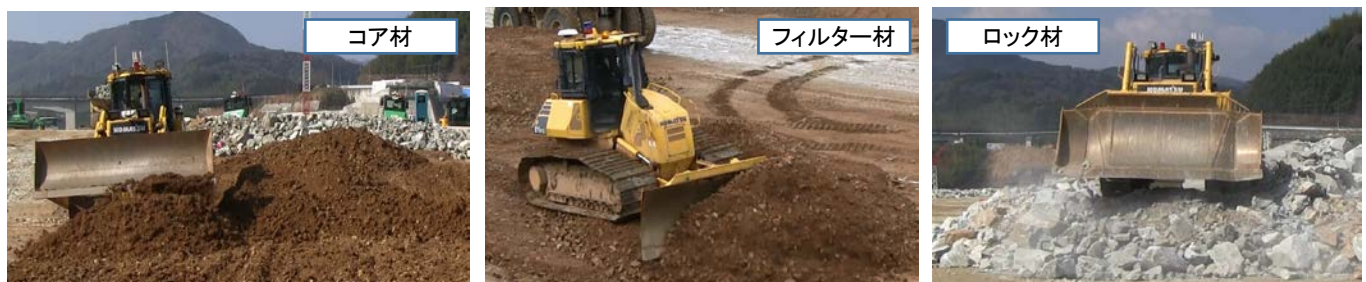
写真-1 自動まき出し施工状況
