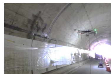
写真 5. トンネル吹付状況
