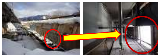
写真4 明かり窓状況
