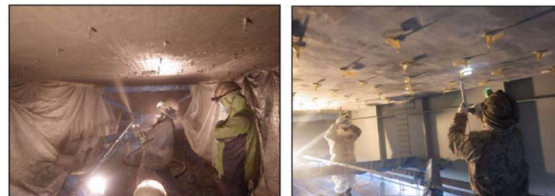
写真3 下面増厚施工状況
