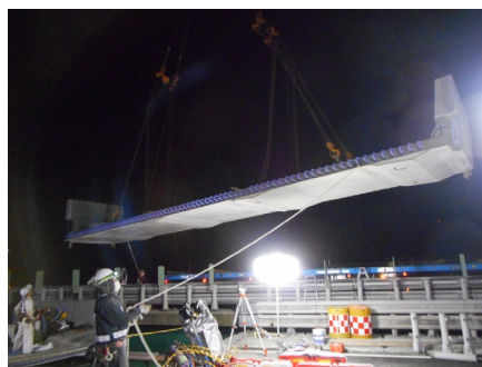
写真2 プレキャスト床版の架設
