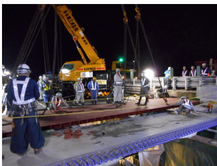
写真1 仮設鋼床版の設置
