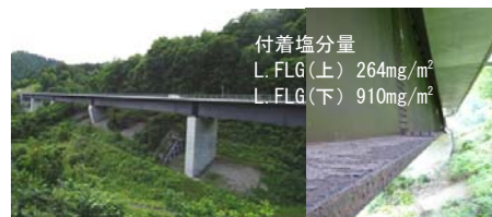
写真3 地山に近接した橋梁
