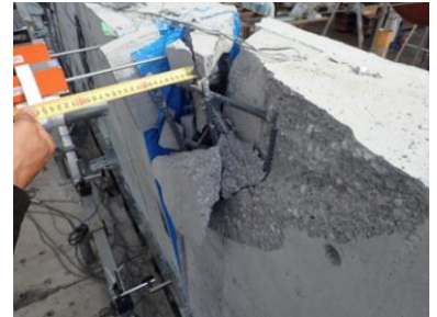
写真-2 RC 中空壁高欄 実験結果（壁高欄背面）
