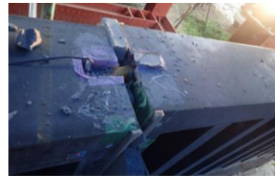
写真-3 UFC 壁高欄実験結果 （接合部間詰材）
