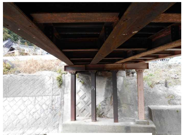
写真-3 橋脚 (H 形鋼)
