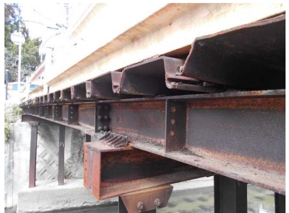
写真-5 床組と矢板 アスファルト
