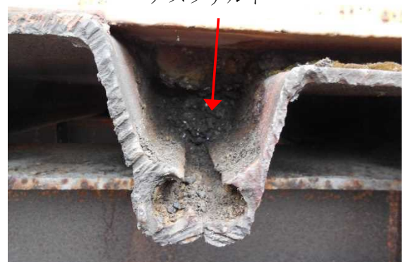
写真-6 矢板内部 (アスファルト)
