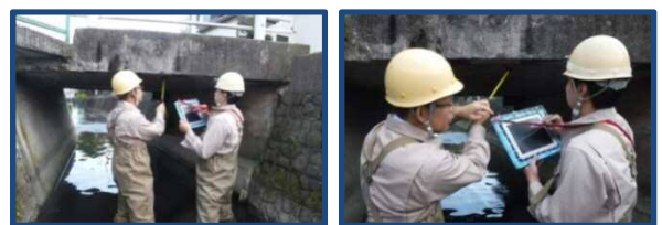
（図-2）直営点検の様子
