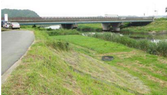
図-2 対象橋梁の全景
