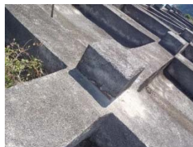
写真-1 頭部保護コンクリート
