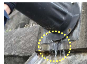
写真-4 流水状況
