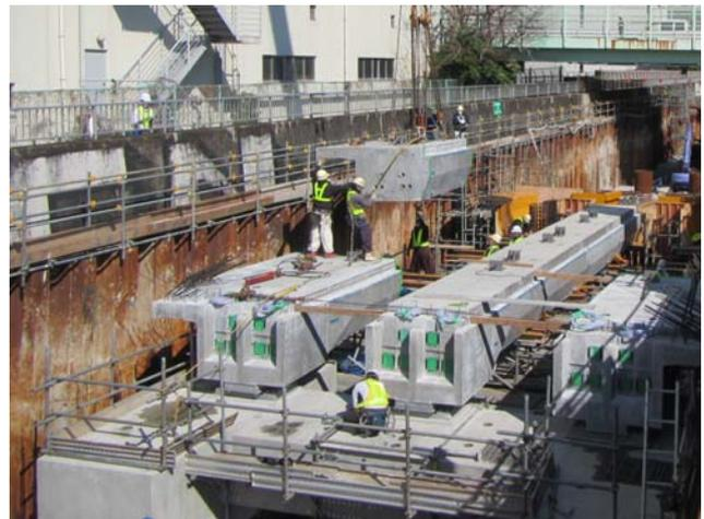
写真-1 PC桁架設状況
