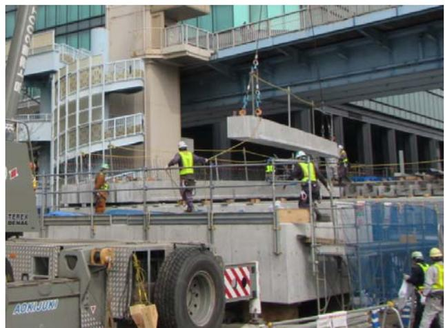
写真-2 プレテン桁架設状況
