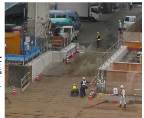
写真-8 八潮橋高架下進入路現況
