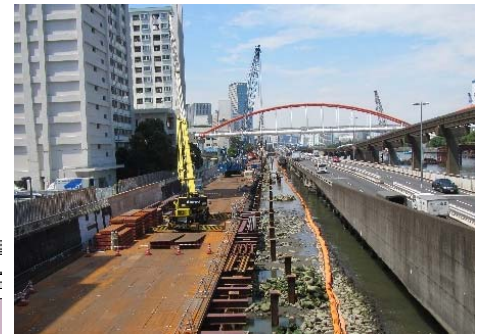
写真-5 海側工事用道路施工状況
