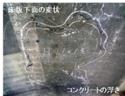
写真-1 床版損傷例
