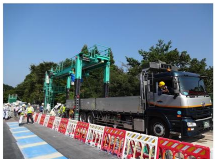
図－7 床版荷卸し状況
