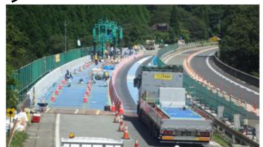
写真-2 工事実施状況
