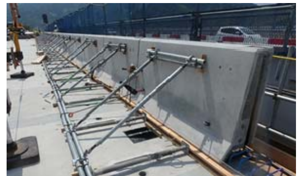
写真-2 プレキャスト壁高欄設置
