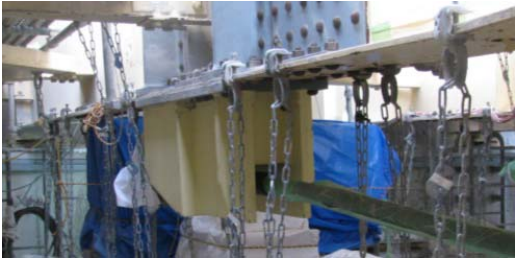
写真-1 外ケーブル設置状況
