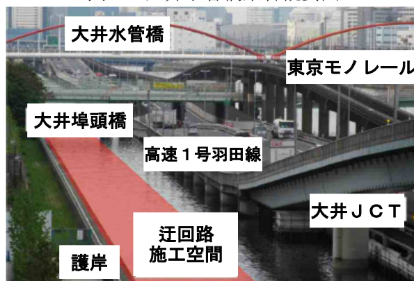
図-6 施工空間状況
