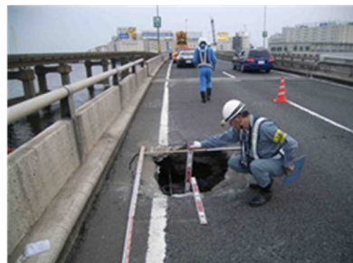
図-3 鯨洲埋立部損傷状況
