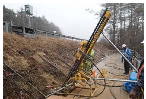
図-6. 盛土補強土工の施工状況
