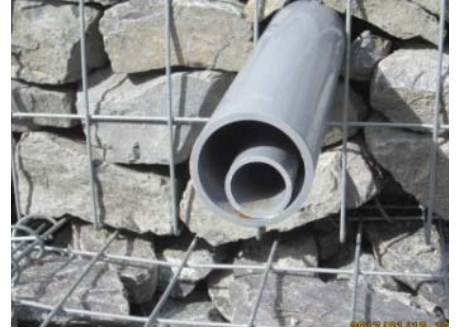
図-4. 孔口保護管設置
