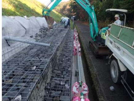
図-3. 水抜きボーリングとかご砕工
