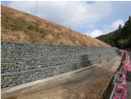
図-2. 盛土内浸透水排除工の施工
