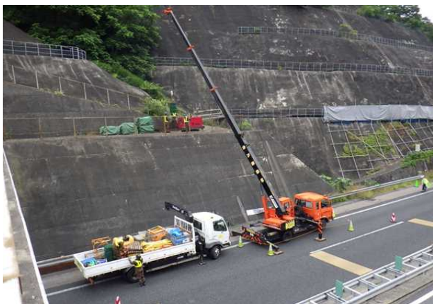
写真-2 交通規制内での資材荷上げ
