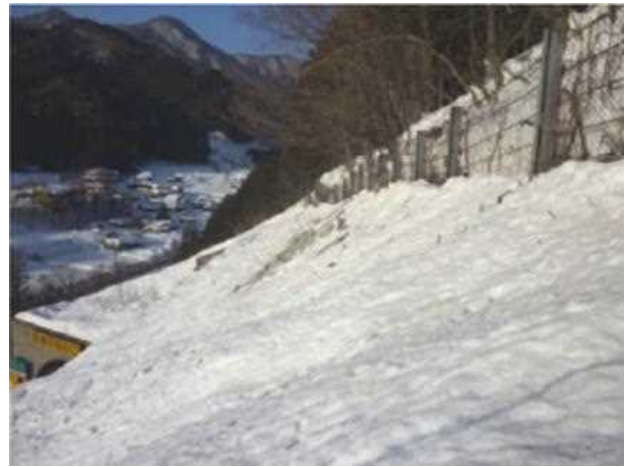
写真-1 落石防止柵（網目 50 mm）をすり抜けた雪
