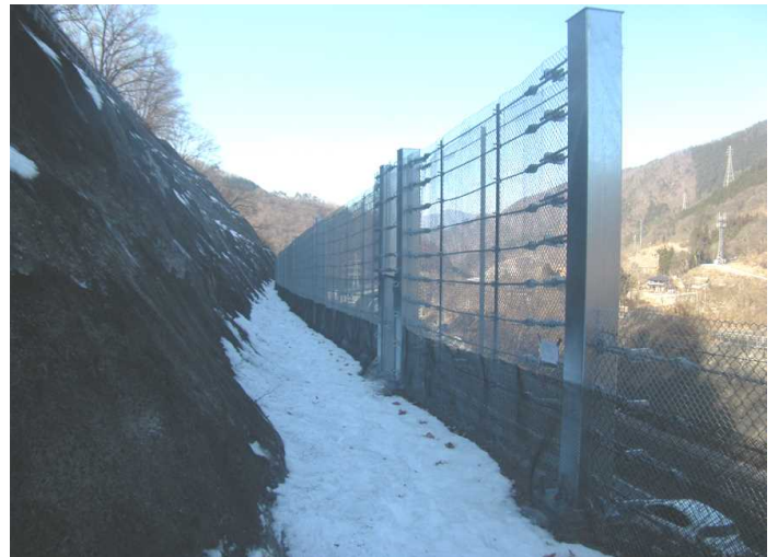
写真-3 完成した落雪防止柵（H=3.0m）
