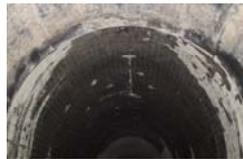
図-3 ケース 4~6 施工箇所の漏水状況(降雨後)
