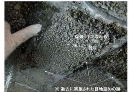
図-1 施工前の覆工の状況
