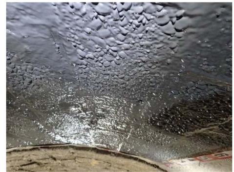
図-6 吹付け完了後の覆工表面
