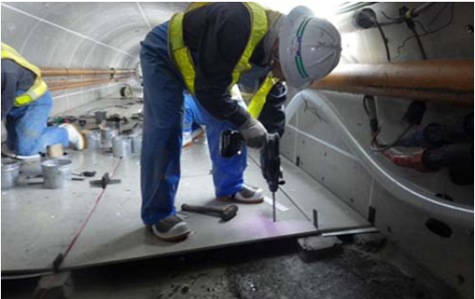
写真-2 インバートパネルの設置状況
