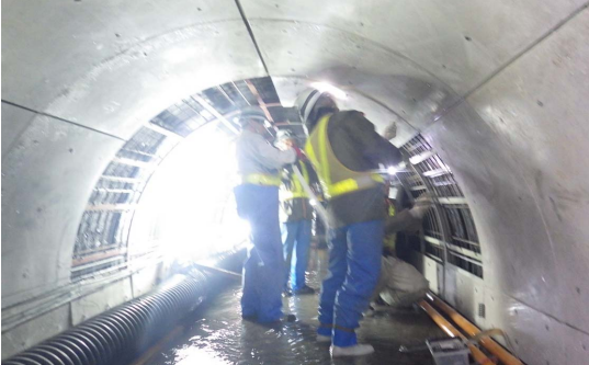
写真-1 アーチパネルの設置状況
