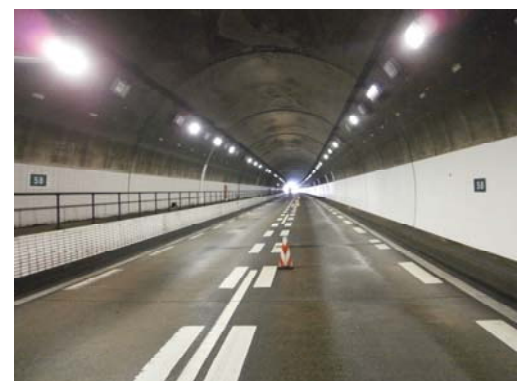
写真-4 更新後のトンネル内視環境 (高立トンネル)
