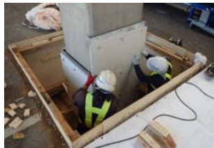
写真-4 CB パネルの組立
