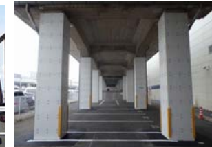
写真-7 施工完了
