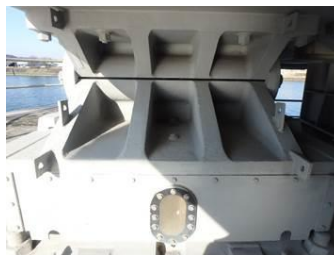
写真-3 油槽付き支承 正面
