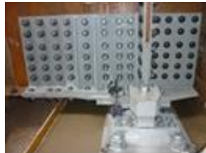
写真-3 恒久対策写真
