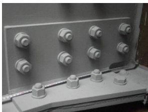
写真-2 応急当て板補強
