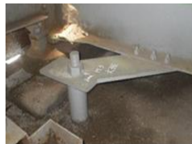
写真-1 変位制限装置
