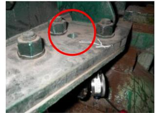
写真3 監視孔設置状況
