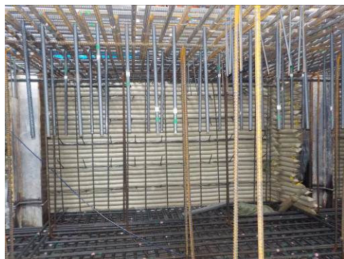
写真-1 エアフェンス設置
