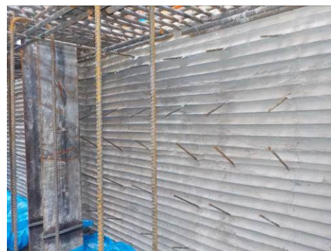
写真-4 エアフェンス撤去後
