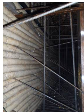
写真-3 打設面側
