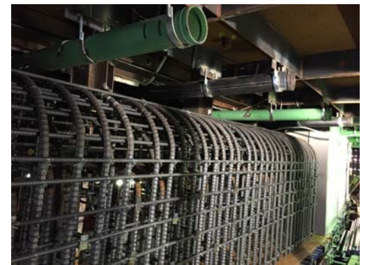
写真-1 鉄筋組立後の鋼殻内状
