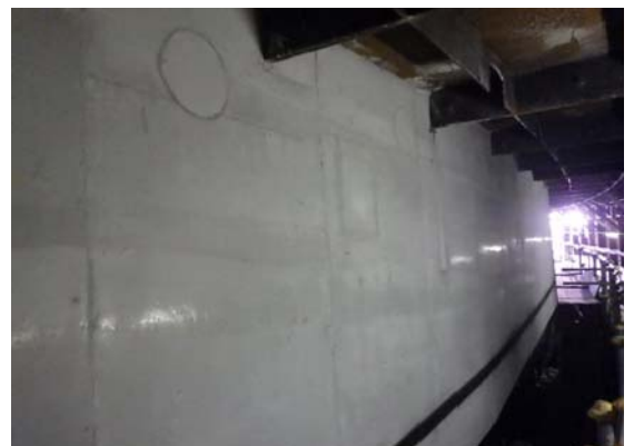
写真-5 高流動コンクリート出来形
