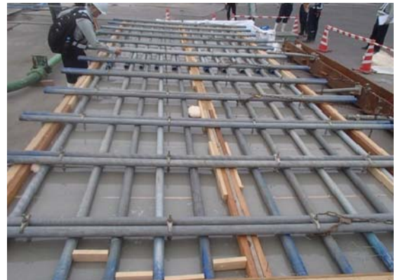
写真-3 実物大実験打設完了状況
