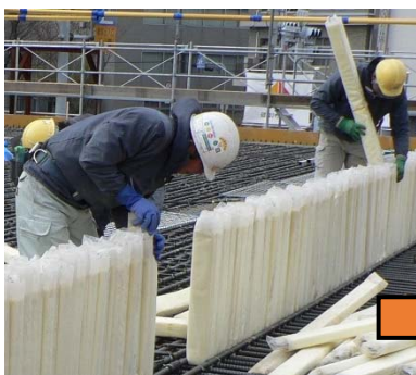
写真－3 スポンジコン止めの設置状況
