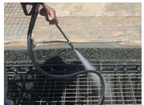
写真－4 打継部の処理状況
