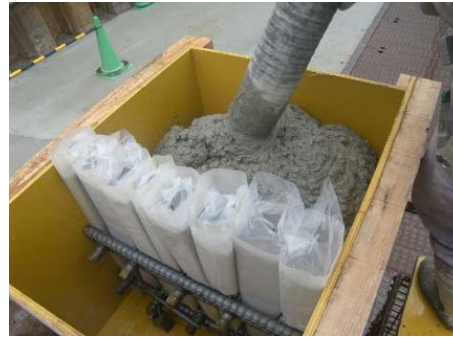
写真－2 試験施工
