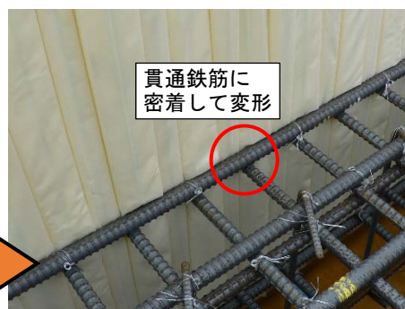
写真－3 スポンジコン止めの設置状況
