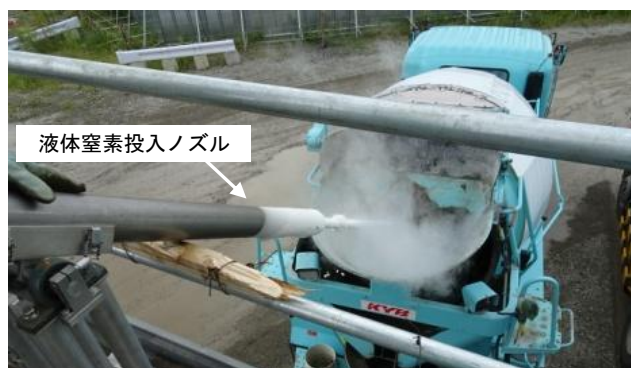
写真-1 液体窒素の投入状況
