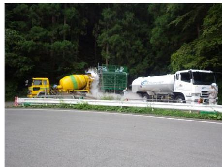
写真-2 液体窒素によるプレクーリング
