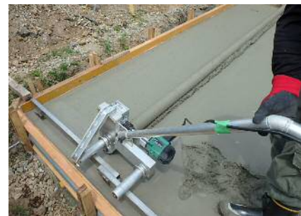
写真-1 レベラー施工状況
