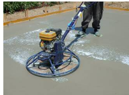
写真-2 トロウエル施工状況
