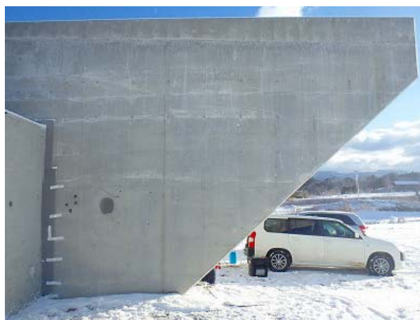
写真-1 透水型枠工法を適用した函渠ウィング部
